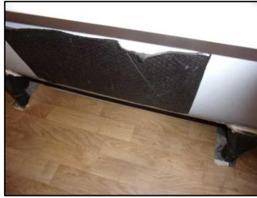
Photo N° 4 ECH-N°002 -RDC droite-Salle de Bains Baignoire Plaque noire bitumineux anti-bruit
