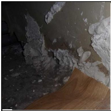
Photo N° 6 ECH-N°004 -RDC droite-Salle de Bains Murs Plâtre / peinture
