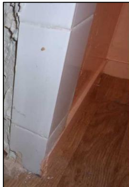
Photo N° 7 ECH-N°005 -RDC droite-Salle de Bains Murs Plâtre / faïence
