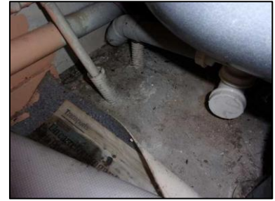
Photo N° 5 ECH-N°003 -RDC droite-Salle de Bains Sol Mortier / béton
